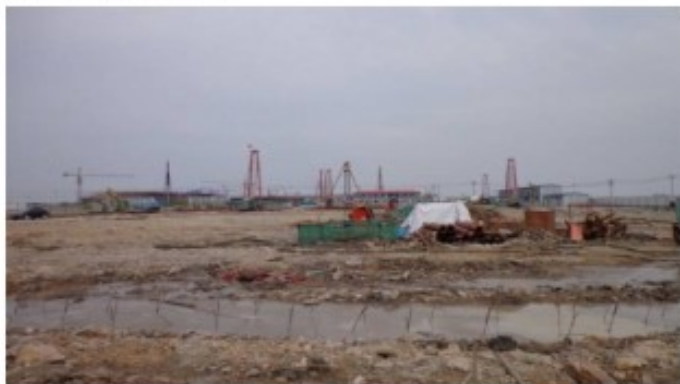
II标施工场景
